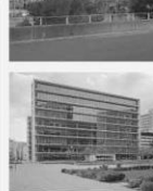
Obras / Construction: Ofício Park Expo - Campus de Justiça de Lisboa Localização / Location: Parque das Nações, Lisboa
